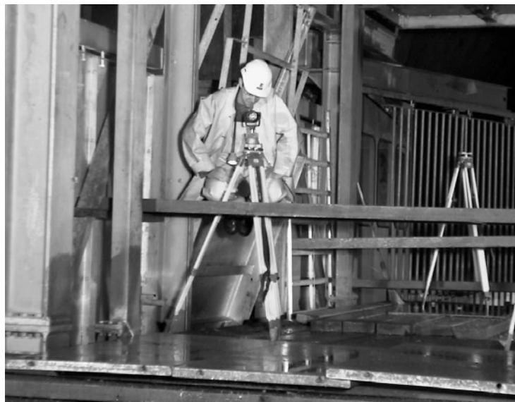
Abb.2: Positionierung der Stative am Schachtfuss
