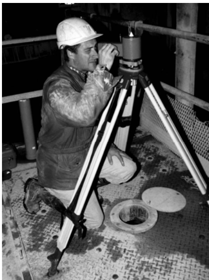
Abb. 1: Nadirlot am Schachtkopf
