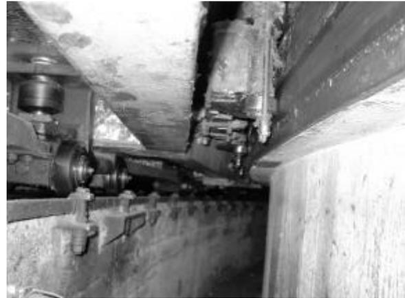
*Auflager und Führung des Drehkörpers*
