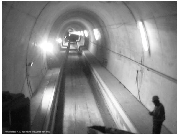
Zimmerbergtunnel: während Bauphase
