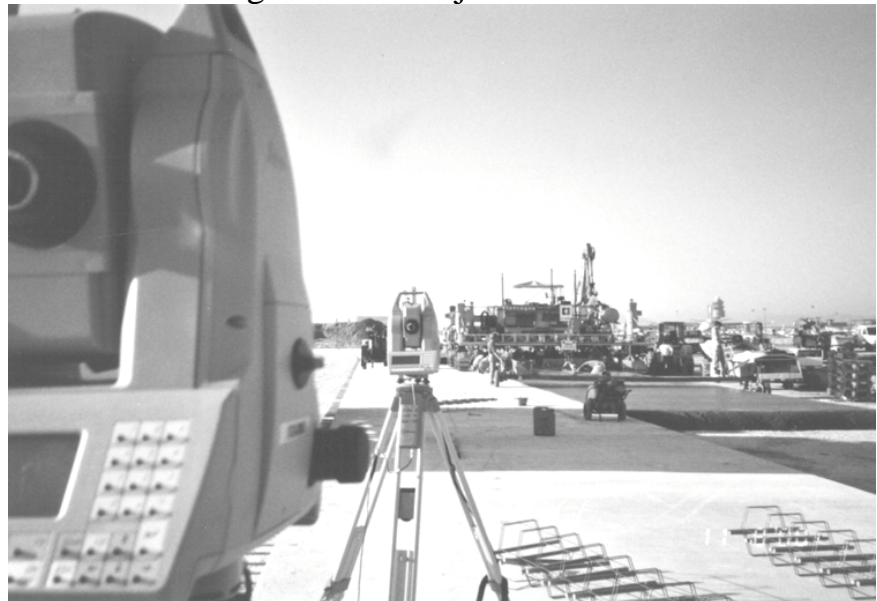
Unique Airport Zürich: Totalstation mit Gleitschalungsfertiger
